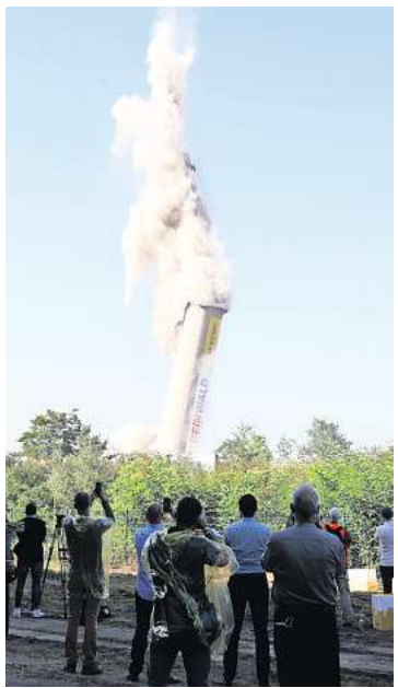
Mit 100 Kilo Sprengstoff wurde der 170 Meter hohe Schlot in der Arno-Nitzsche-Straße am 10. September 2023 zum Einsturz gebracht. FOTO: ANDRÉ KEMPNER
